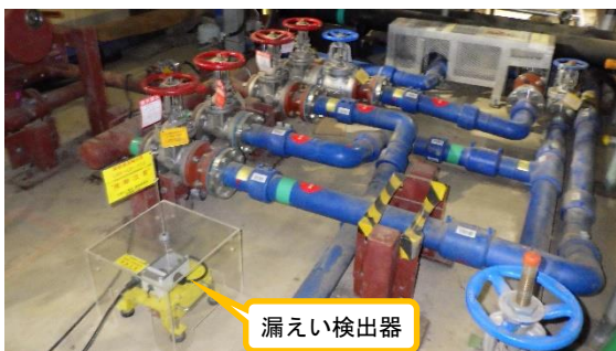
(写真2) 炉注水ポンプ配管周辺の状況
