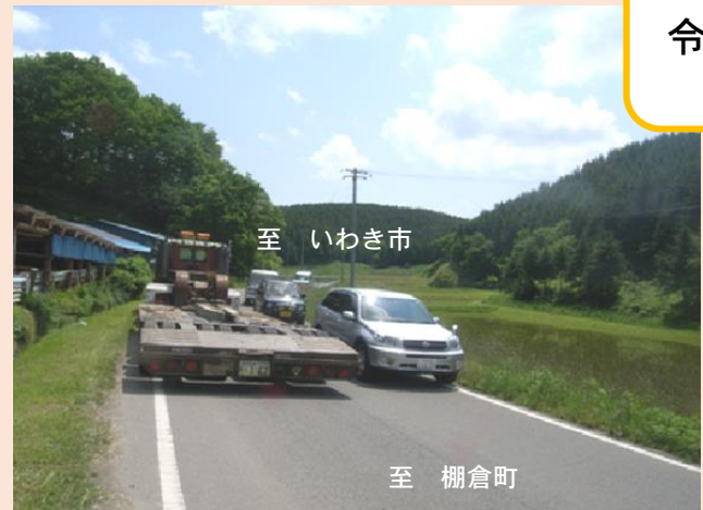
工事着手前 (平成25年度)
