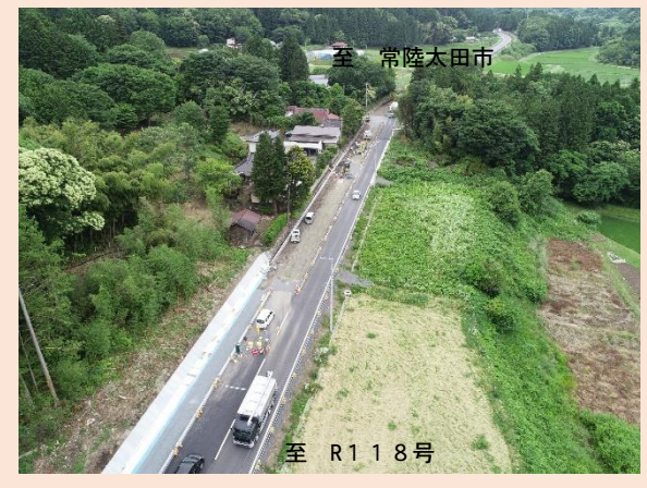
② 3工区 施工状況
