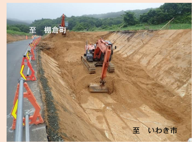
② 2工区 路面掘削状況 (片側交互通行)
