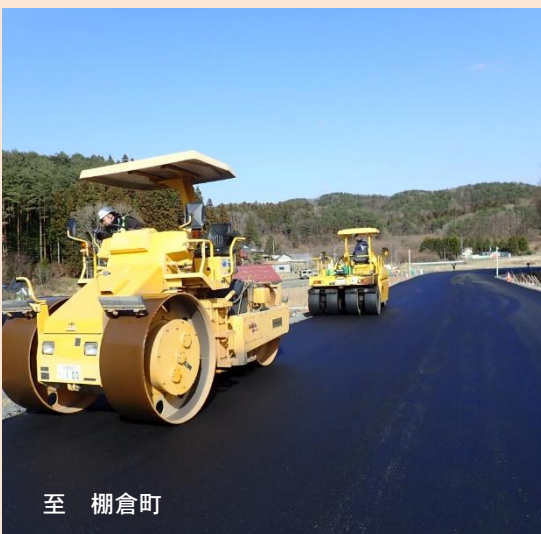
② 2工区 舗装施工状況
