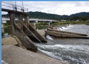
伊香堰頭首工、 改修工事に着手
