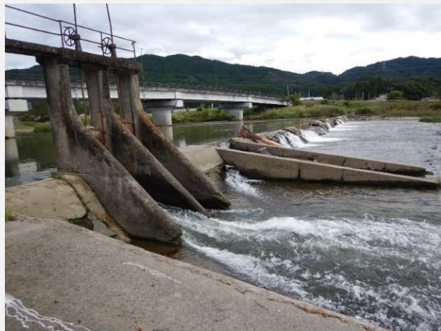
改修工事前の伊香堰頭首工
