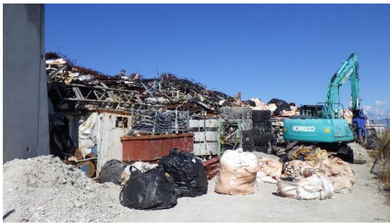
(写真 2-3) 一時保管エリア P 1 東側の状況 (令和 4 年 1 0 月 3 1 日、写真 2-2 のトラックの北側において南側に向かって撮影)
