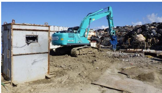
(写真 4) 一時保管エリア P 1 東側の瓦礫の移送先である第二土捨場の状況
