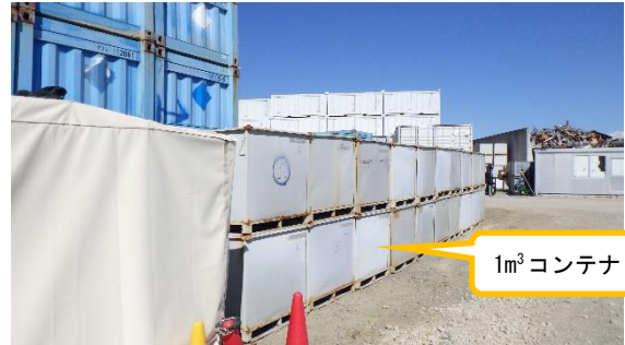
(写真1-2) ノッチタンクが設置されていた箇所の状況 (令和4年10月31日、南東側から撮影)
