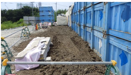
(写真1-3) ノッチタンクが設置されていた箇所の状況 (令和4年8月9日、北側から撮影)
