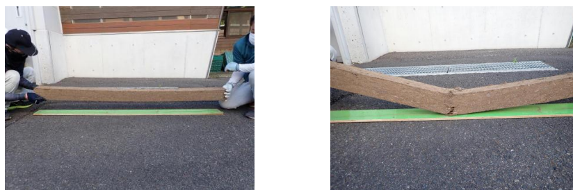
図-1 棒状試験体の折損状況 (バーク 3 : セメント 7、200kN荷重)
