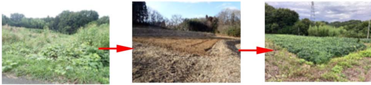
①R3年度耕作放棄地解消工事【西田町土棚地内】
