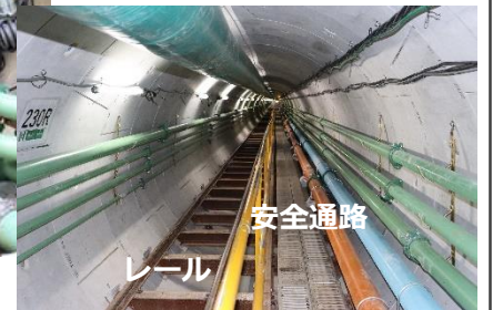
トンネル内部安全設備の整備状況
