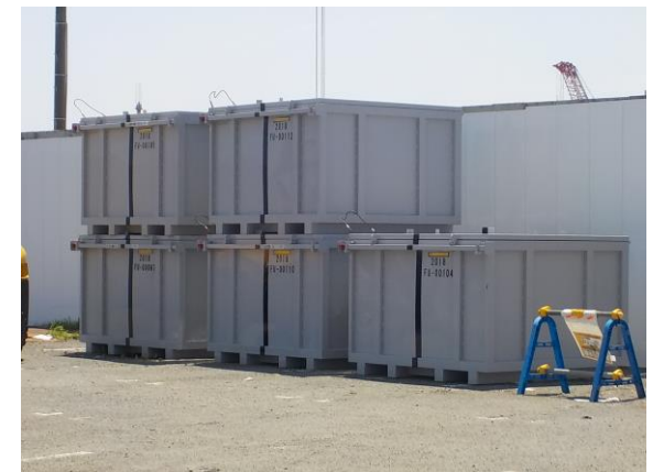
腐食コンテナの詰め替え 6m³コンテナへ詰め替え
