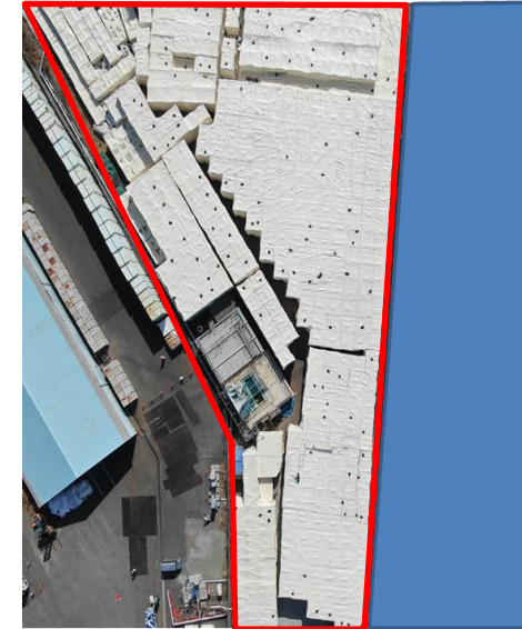
耐候性シートへのリブレース完了 一時保管エリアW1
