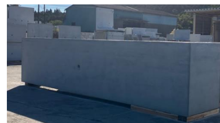
上流水槽側壁
