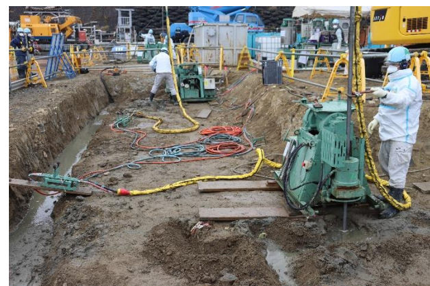
地盤改良の状況
