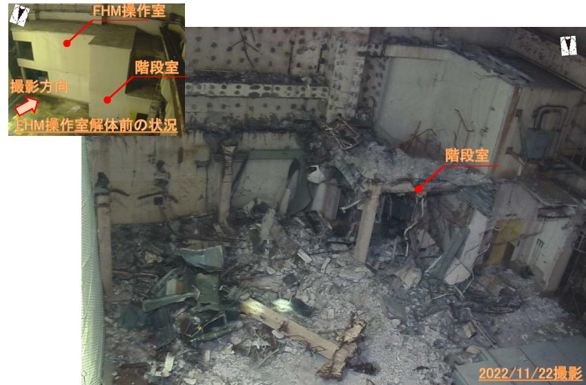
解体中の現場状況写真
