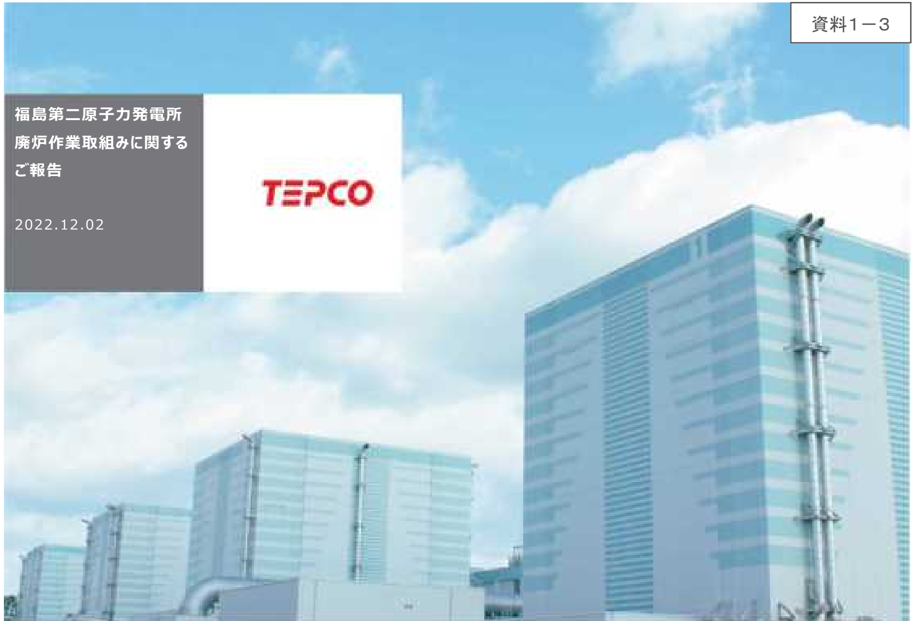
福島第二原子力発電所
