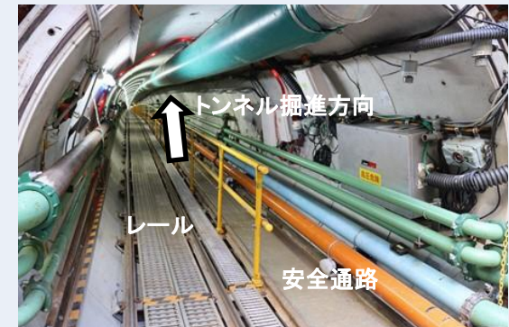
トンネル内部安全設備の整備状況 トンネル掘進を実施中 約656m/約1,030m<11/21現在>
