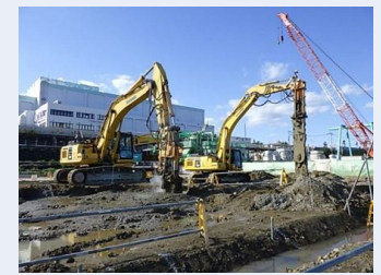
地盤改良の状況
