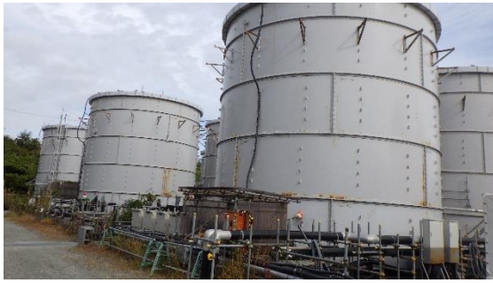
(写真1) F1タンクエリアの状況
