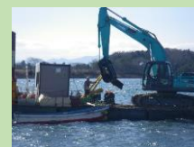
漁場内のがれき等の除去作業
