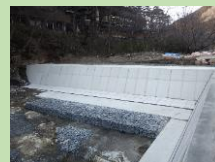
老朽化した頭首工の補修
