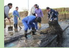
地域ぐるみでの堰の土砂上げ作業
