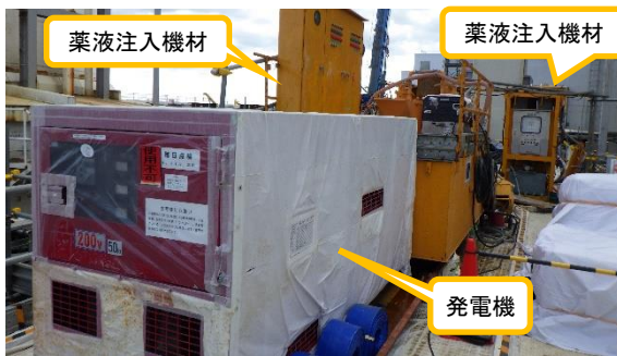
(写真2) 薬液注入工事用機材の設置状況① (全体)
