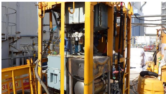
(写真3-2) 薬液注入工事用機材の設置状況③(粒子の細かい薬液を注入。)
