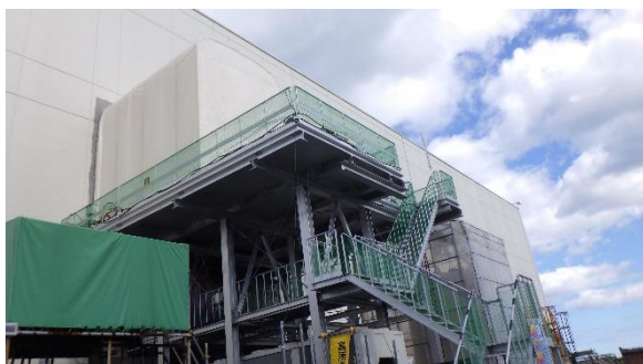
(写真6) プロセス主建屋南側壁面の状況
