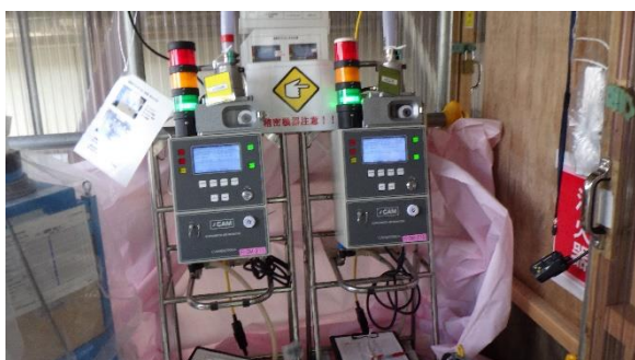
(写真7) ダストモニタ設置の状況
