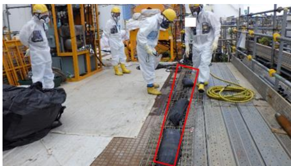
(写真4) 薬液注入工事の実施箇所の状況
