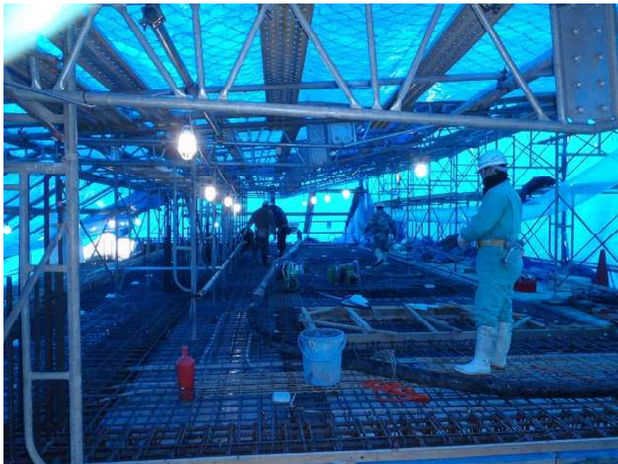
コンクリート採暖養生（平成24年2月16日撮影）
