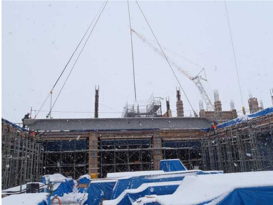
P C 床板取付工事状況（平成24年2月25日撮影）
