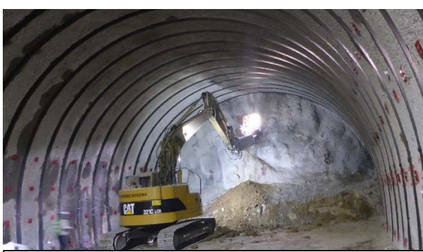
国道114号 川俣町工区関場トンネル 令和4年3月2日 貫通
