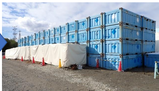
(写真 1 - 2) ノッチタンクが設置されていた箇所の状況（令和 4 年12月19日北側から撮影）
