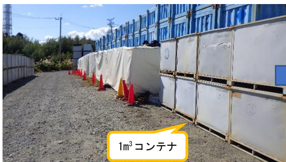
(写真 1 - 1) ノッチタンクが設置されていた箇所の状況（令和 4 年10月31日、北側から撮影）
