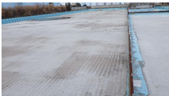
(写真 3) E タンクエリア (追設一時保管エリア EE 1 設置予定) の状況
