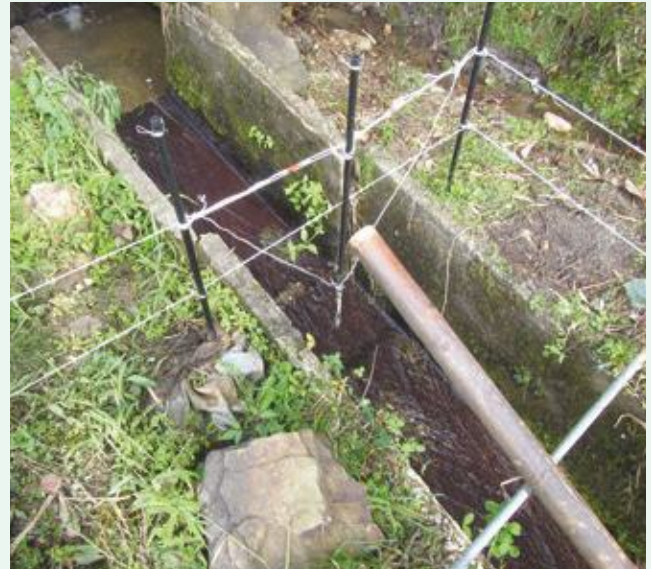
水路のすき間にも柵線を設置! すき間から侵入されることがないようにしました!
