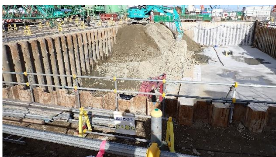
(写真2) 放水立坑（上流水槽）の状況 （南側から撮影）
