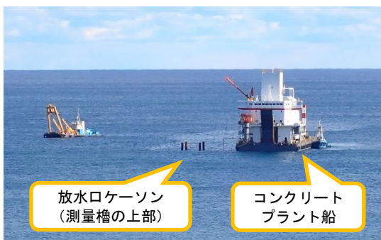
(写真1) 沖合での作業状況
