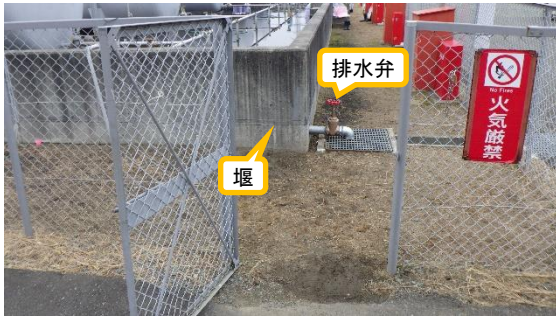
(写真3-2) 堰の排水弁の状況
