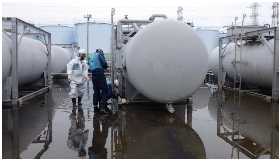
(写真4) 油面計元弁の閉操作実施の状況
