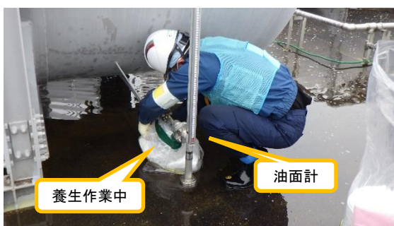
(写真2) 油漏えい拡大防止対策の実施状況
