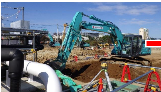
(写真5-1) エリア整備作業の状況① (令和4年 10月28日撮影)
