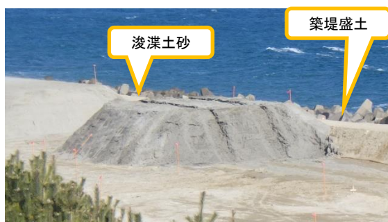
(写真3) 浚渫土砂の保管状況
