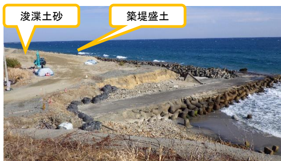
(写真1) 浚渫土砂の置き場概観
