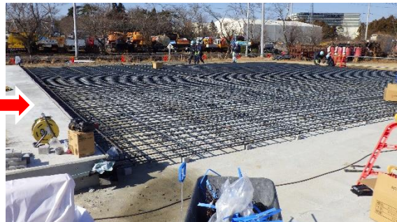
(写真5-2) 鉄筋組み立て作業の状況①
