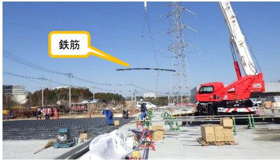
(写真5-3) 鉄筋組み立て作業の状況②
