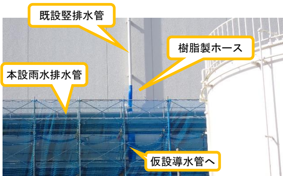
(写真 3 - 2) 既設縦排水管の状況② (東側から撮影)
