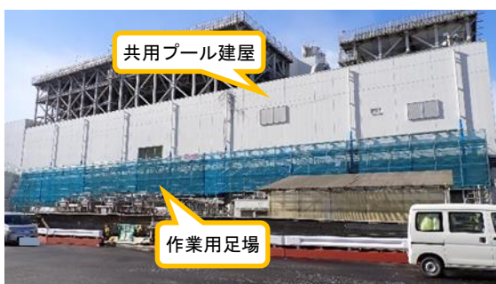
(写真1) 共用プール建屋の概観 (北東側から撮影)
