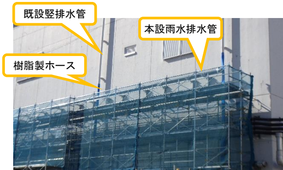
(写真 3 - 1) 既設縦排水管の状況① (北東側から撮影)
