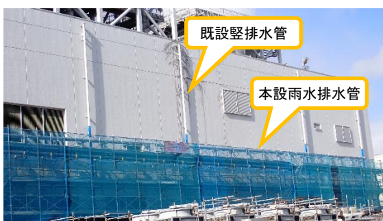
(写真2-1) 共用プール建屋東壁の本設雨水排水 管の設置状況 (南東側から撮影)
