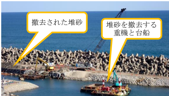
(写真2) 重機を載せた台船 (南西側から撮影)
