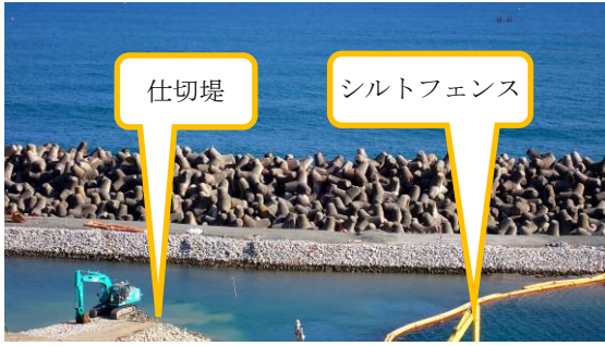
(写真1) 仕切堤の設置工事の状況 (南西側から撮影)
