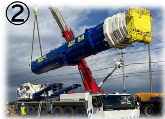
② 《メインクレーン組立》
