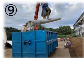
⑨ 《産廃(ブレード)搬出》
