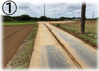
① 《整地・鉄板敷設》
