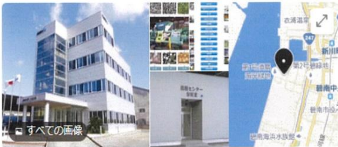
(株)豊栄商会碧南工場 リサイクルセンター
