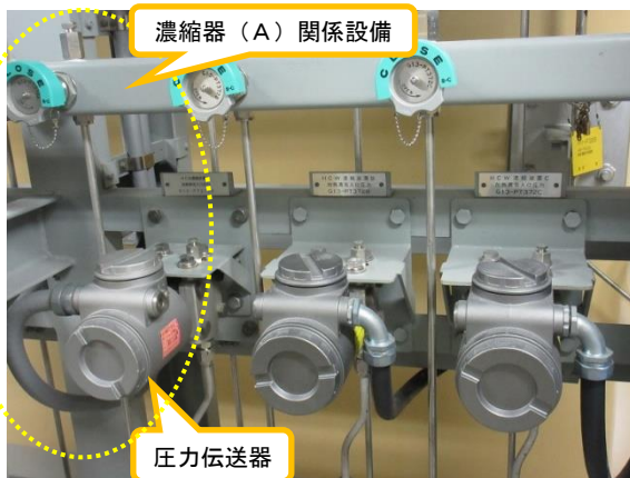
(写真3) 高電導度廃液系の濃縮器（A）の状況
