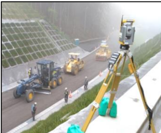
ICT建機による3D施工状況
