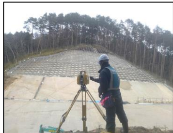
3Dレーザースキャナによる計測状況
