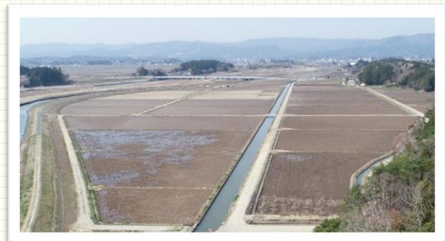
↑担当した地域の整備後のほ場
