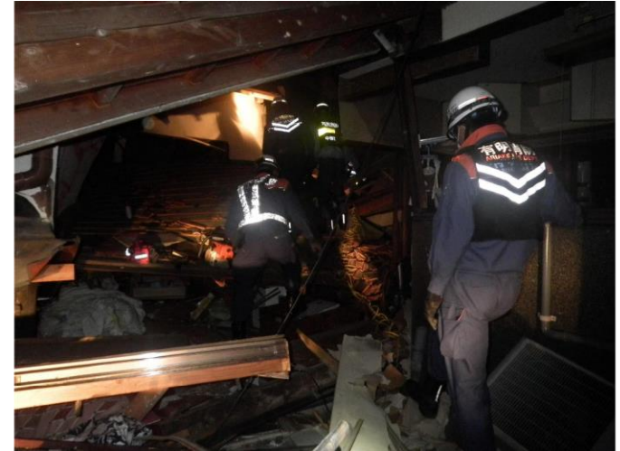
写真：有明応援隊の活動風景 倒壊建物からの救出作業 (熊本災害デジタルアーカイブより)
