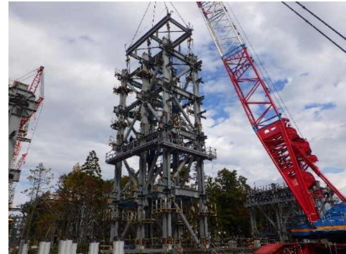
鉄骨ユニット接合確認状況(2022.11.5)
