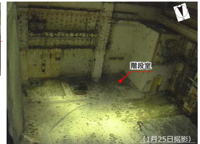
解体後の現場状況写真(2023年1月25日撮影)
