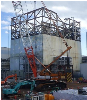
1号機原子炉建屋現場状況
