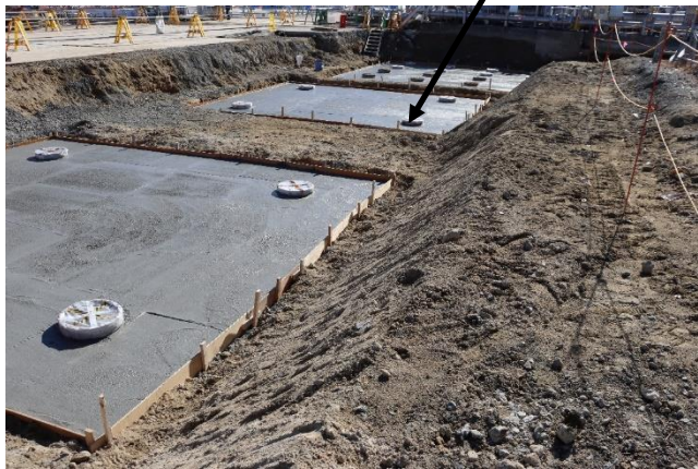
海水移送配管基礎の構築状況
