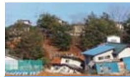
家屋被害：福島市
