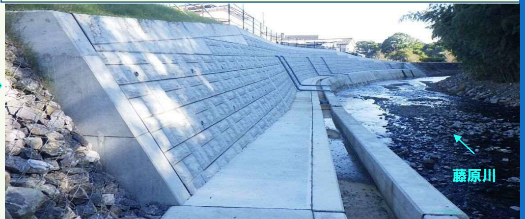
護岸工事 (完了)
