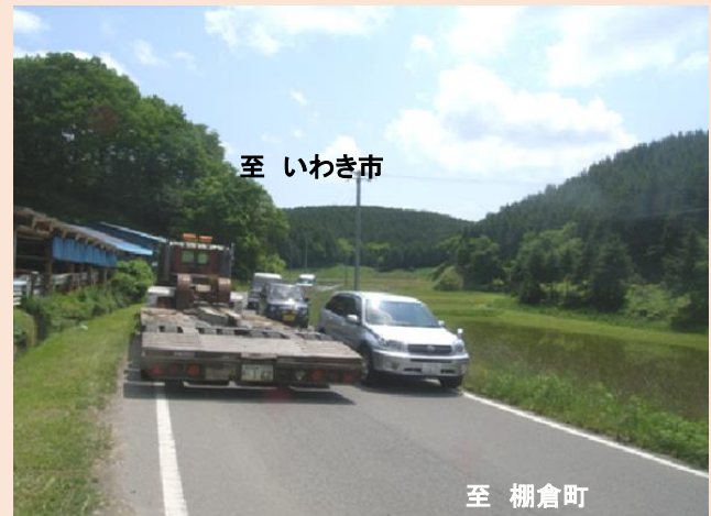
工事着手前(平成25年度)
