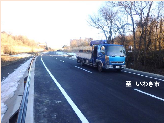
① 2工区 整備後
