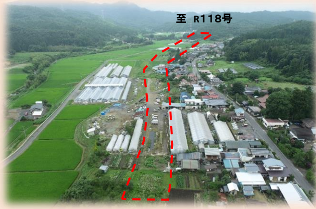
①整備前(2工区)
