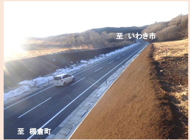
② 2工区 整備後
