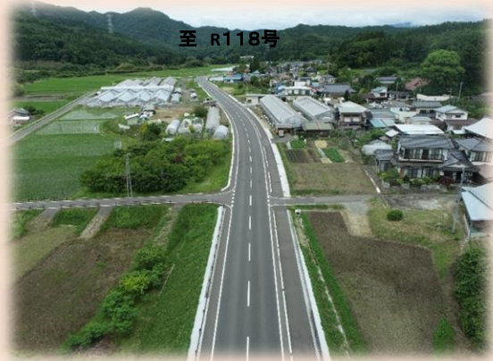
②整備後(2工区)
