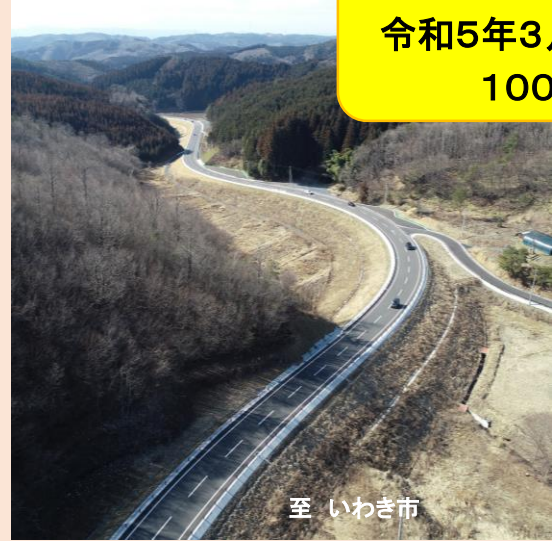
② 2工区 整備後
