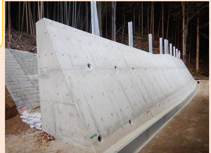
施工状況写真
