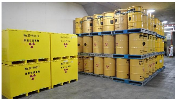
(写真2-1) 第4棟における廃棄物の保管状 況
