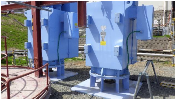
(写真3) 三相誘導電動機の仮置き状況
