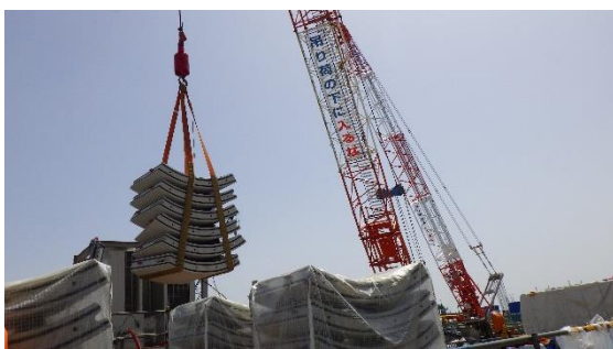
(写真6) セグメントの搬入状況
