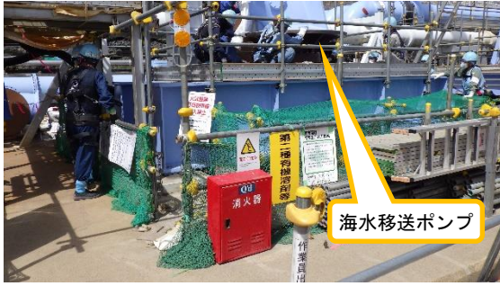
(写真1-1) 海水移送ポンプ設置工事の状況①
