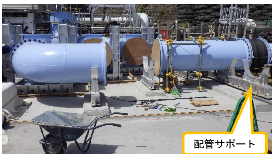
(写真2-2) 海水移送配管（水色の配管）設置状況②
