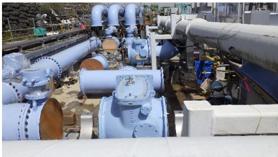
(写真2-1) 海水移送配管（水色の配管）設置状況①
