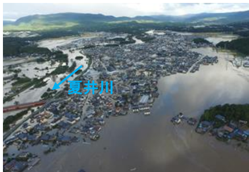
東日本台風による被害状況
