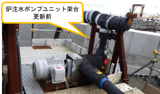
(写真 5 - 1) 炉注水ポンプユニット架台更新前の 状況 (令和 2 年 1 1 月 1 1 日撮影)
