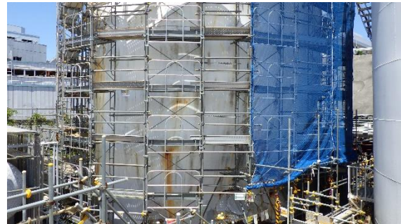
(写真1-2) No. 1 重油タンクの状況 (南東側から撮影) (今回撮影：令和5年5月11日)
