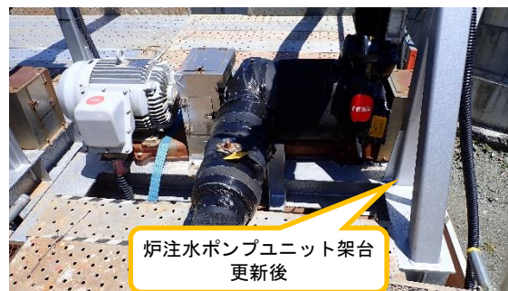
(写真 5 - 2) 炉注水ポンプユニット架台更新後の 状況 (令和 5 年 5 月 1 1 日撮影)
