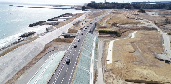
井出・波倉工区(檜葉町)
