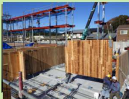
CLT壁パネルの建込状況
