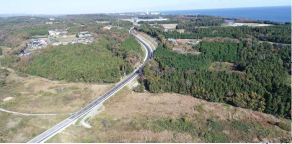
井出・波倉工区 開通式(R4.12)
