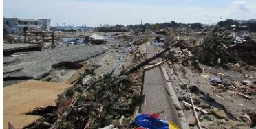
被災状況 (谷地小屋地区海岸)
