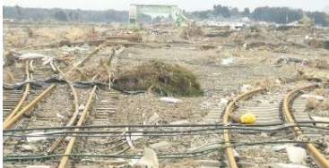
被災状況 (JR新地駅周辺)
