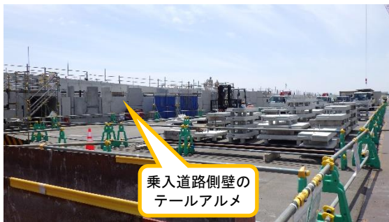
(写真 2 - 1) 北側乗入道路の整備状況① (1号機東側を北西側から撮影)
