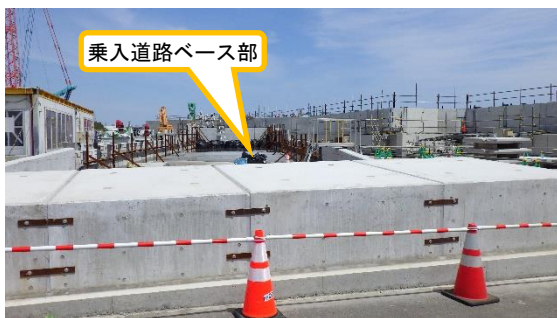
(写真 2 - 2) 北側乗入道路の整備状況② (1号機東側を南側から撮影)
