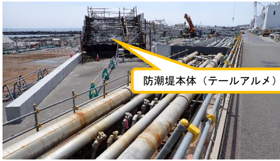
(写真 1 - 3) 防潮堤本体の状況③ (防潮堤北端部を北側から撮影)
