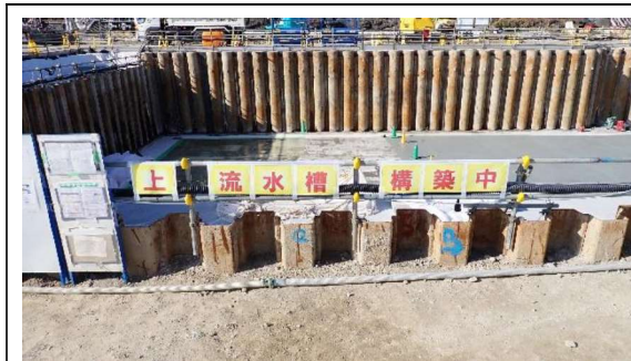
（写真1-1）放水立坑（上流水槽）の構築工事の状況①
