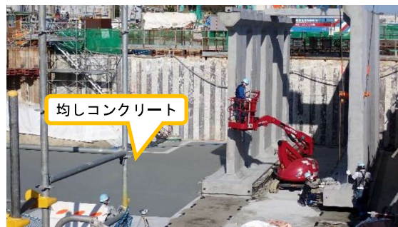
（写真1-3）放水立坑（上流水槽）の構築工事の状況③
