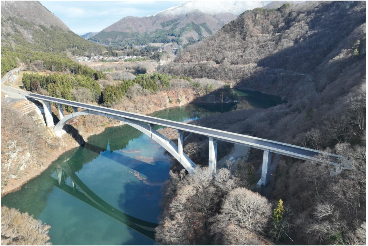
国道118号小沼崎バイパス「下郷大橋」(下郷町)
