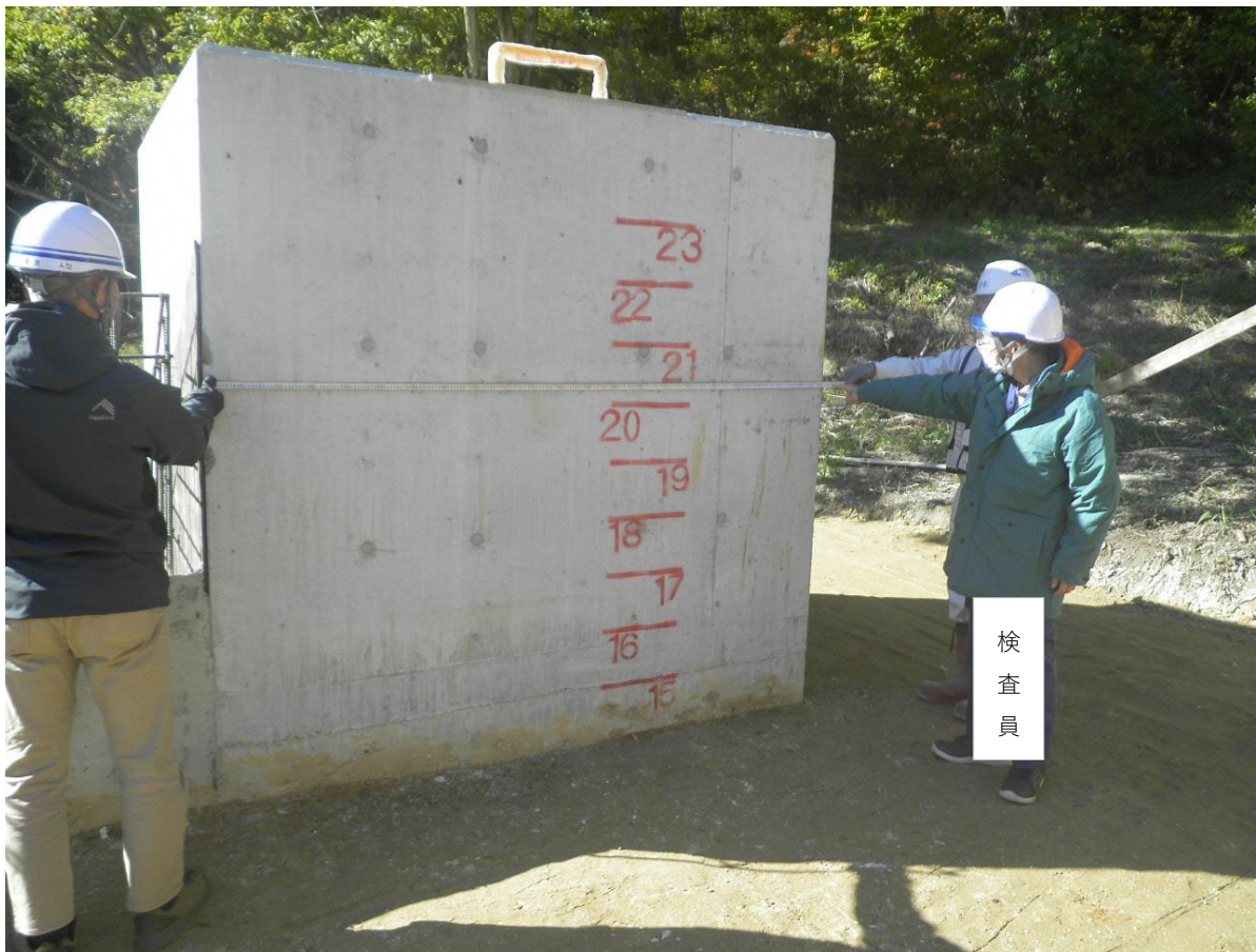
※ため池の洪水吐の出来形を確認。構造物の幅を計測。
