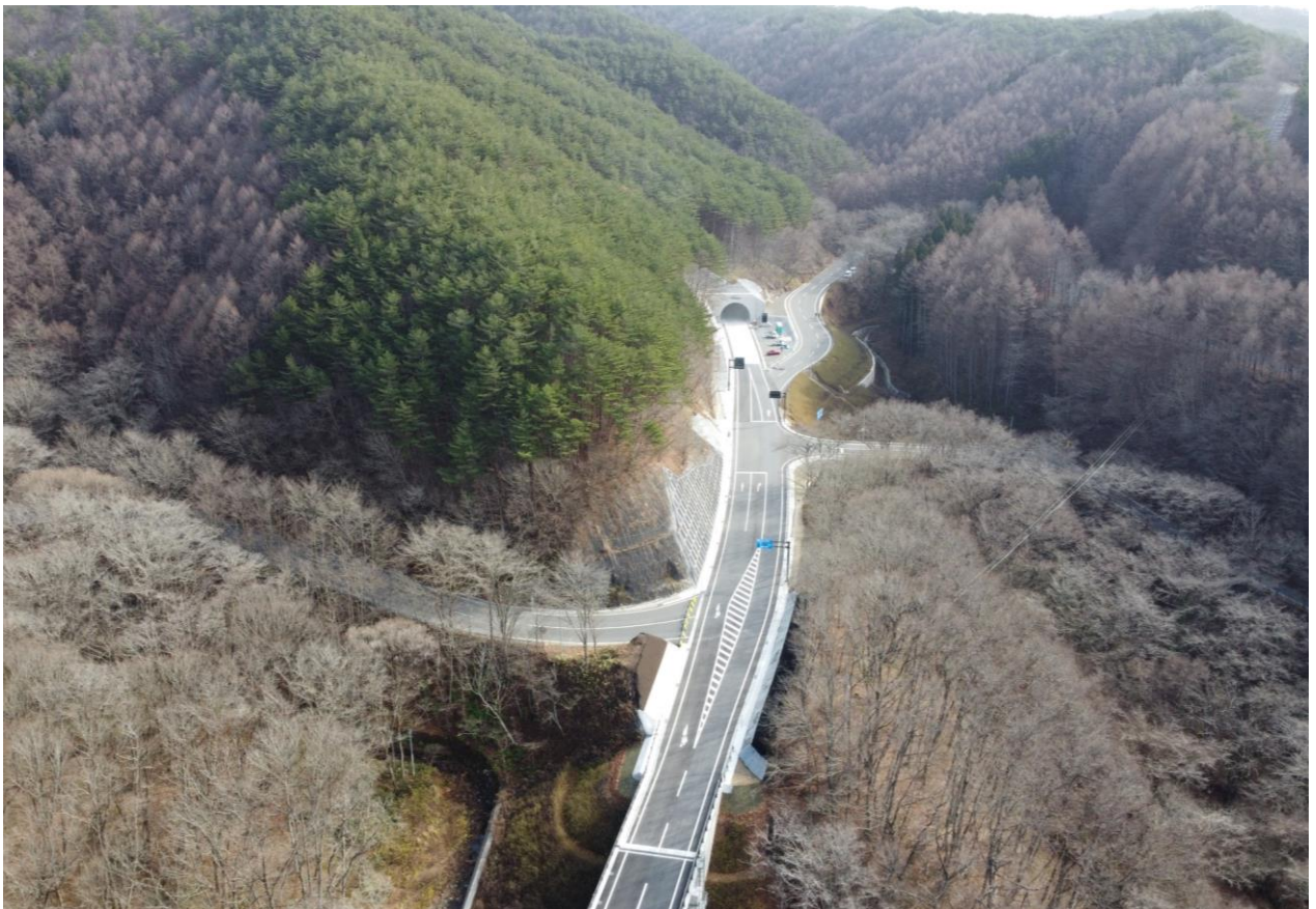
国道118号鳳坂工区(天栄村)
