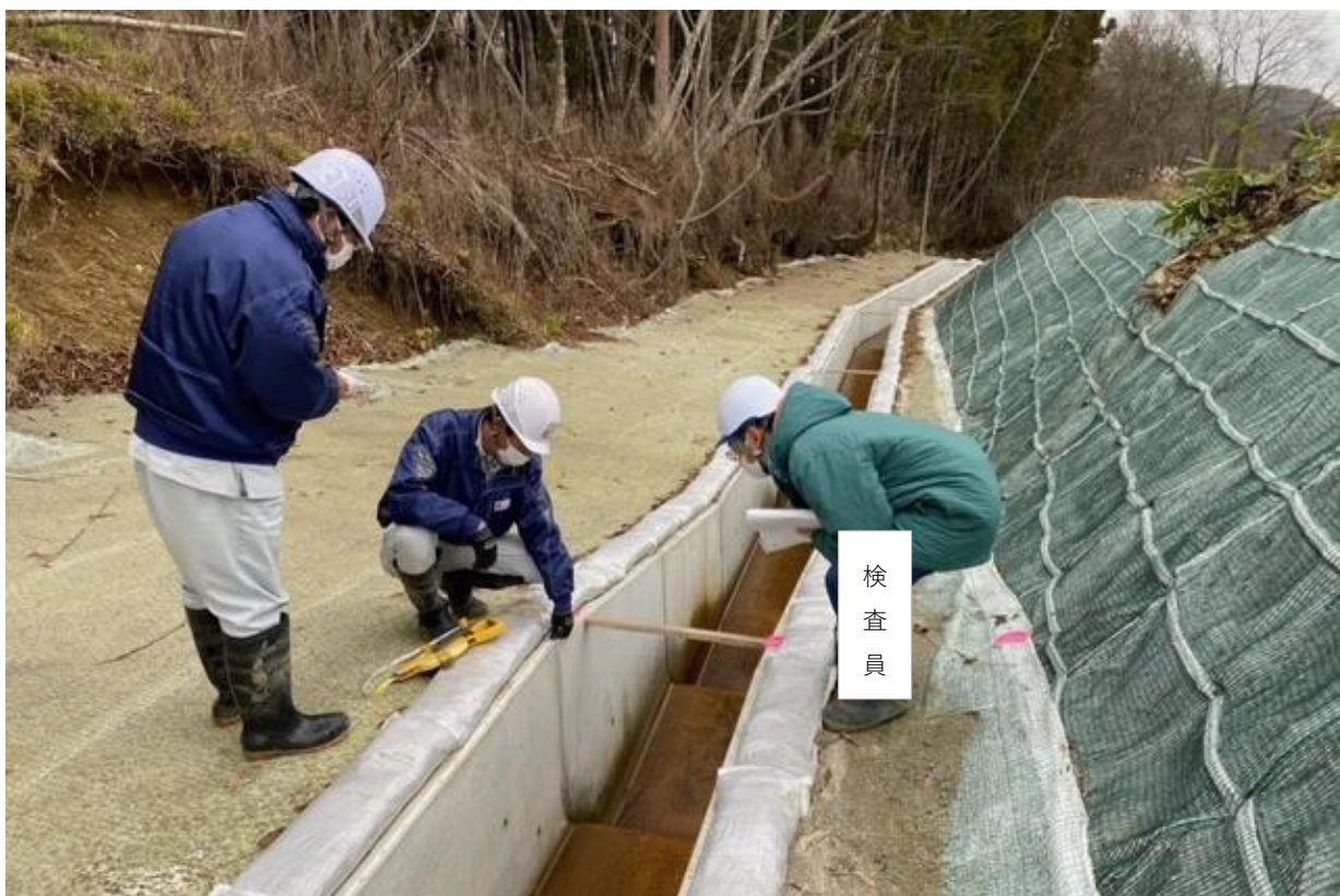
※水路工の出来形を確認。設置された水路の長さを計測。
