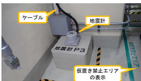
(写真2-1) 6号機原子炉建屋地下2階の地震計 (P3)の状況
