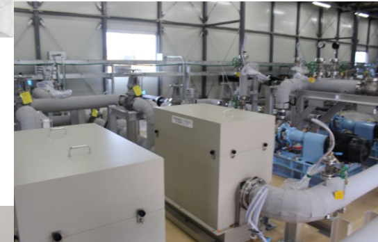
◀ ALPS処理水移送設備 (緊急遮断弁)
