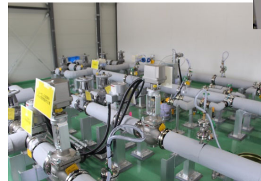
◀ ALPS処理水移送設備 (緊急遮断弁)
