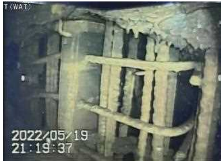
アクセス開口部付近 調査状況
