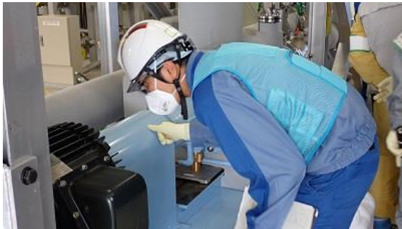
(写真 4) 循環ポンプ起動後の確認状況
