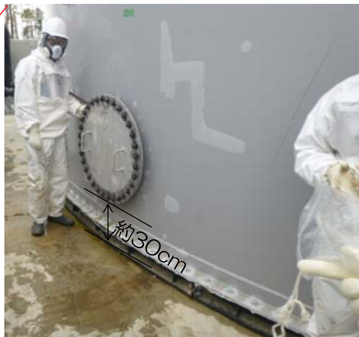
サンプルタンクC側面マンホール写真
