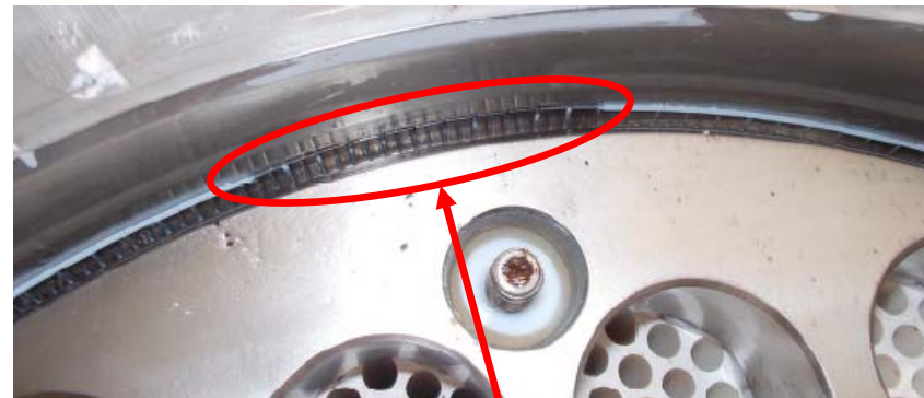
押さえプレート上面より撮影
