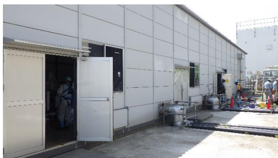
(写真1-2) 多核種移送設備建屋
