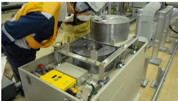
(写真 2 - 2) 検査の状況①
