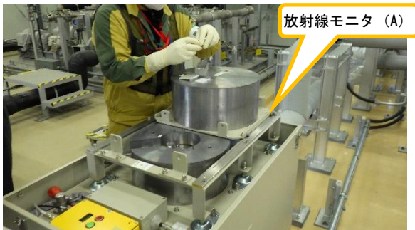
(写真2-1) 放射線モニタへの標準線源設置の状況
