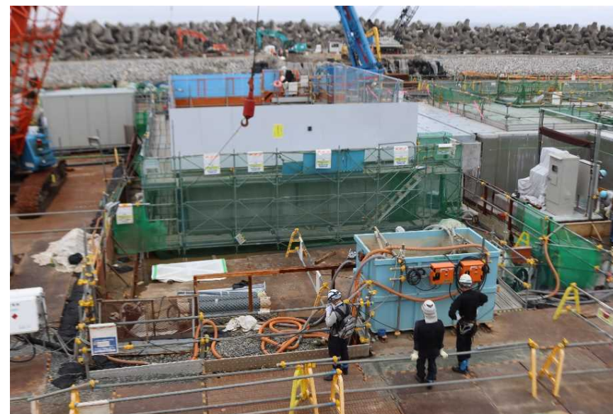
放水立坑（下流水槽） 全景
