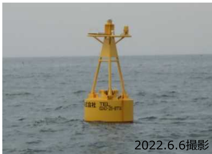
灯浮標設置状況
