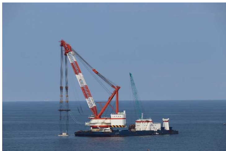
放水蓋設置作業の状況①
