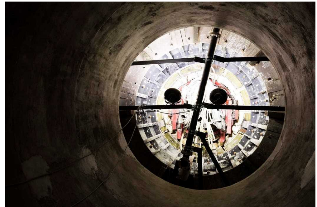
トンネル先端状況
