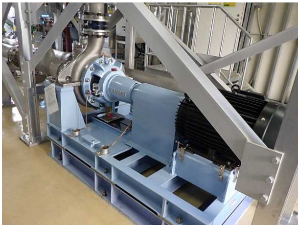
循環ポンプ設置の状況
