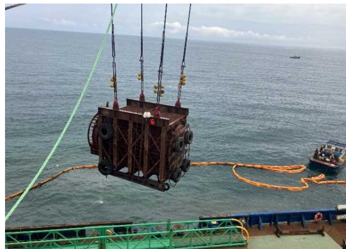
到達管の撤去作業の状況②
