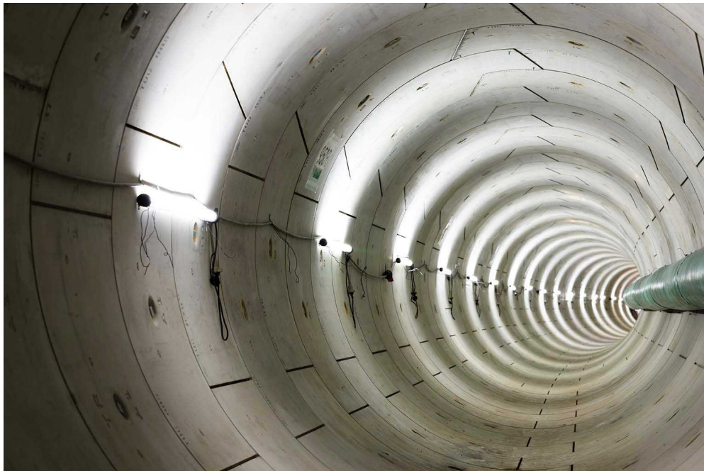
トンネル内部の状況
