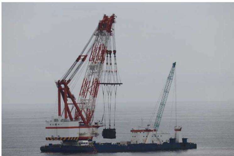
到達管の撤去作業の状況①
