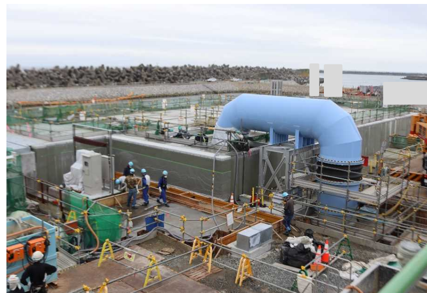
放水立坑（上流水槽） 全景
