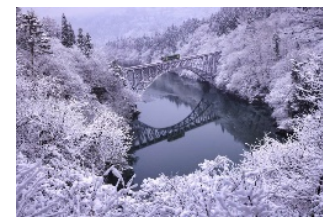
只見線鐵道設施群
