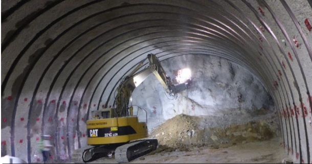
國道114号 川俣町工區關場隧道 2022年3月2日 開通
