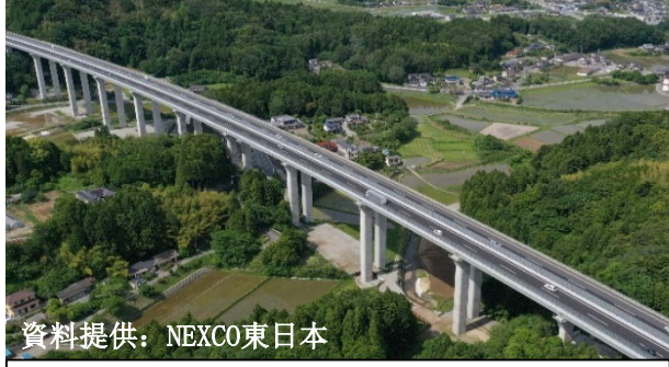
資料提供: NEXCO東日本 常磐自動車道 (磐城中央IC~廣野 IC) 2021年6月13日 開始運用4車道
