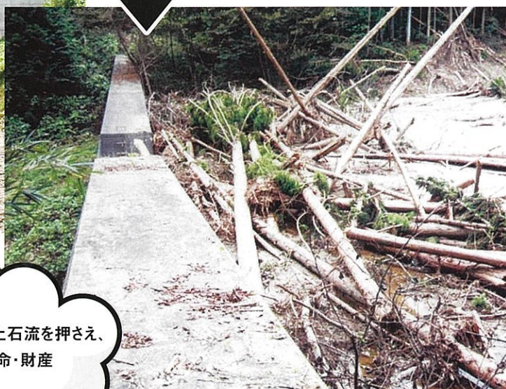
写真：千沢筋 西白河郡大信村十日町地内 砂防えん提平成10年8月末日の豪雨によ り発生した土石流を砂防えん提が止めた 状況写真
