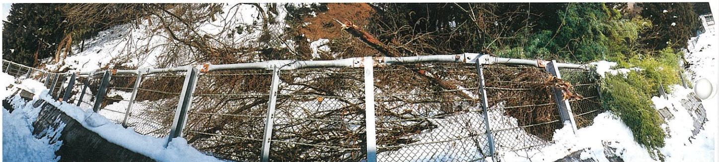
擁壁工と落石防護柵で崩壊土砂をくい止めた
