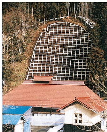
法面工施工後 (再度崩壊防止のため、法面工を施工)
