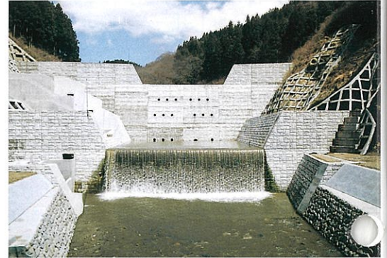
那倉川 砂防えん堤
