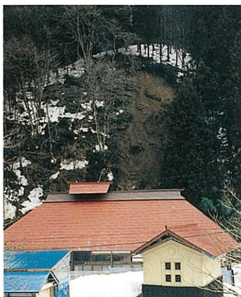
法面工施工前(斜面崩壊跡)
